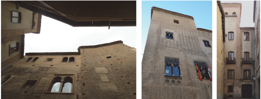
Figura 5.- Callejón de la plaza platero Oquendo, con las dos torres de las casas fortaleza. Casa de los Cascales Barros y al fondo del callejón Casa Oquendo nº 2 (fotos autora).
