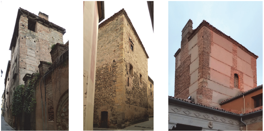
Figura 3.- Tres de las torres medievales del interior del recinto amurallado, con diferente técnica constructiva. Torre Diego de Rueda, convento Dominicas y torre interior de Lozoya (fotos autora).
