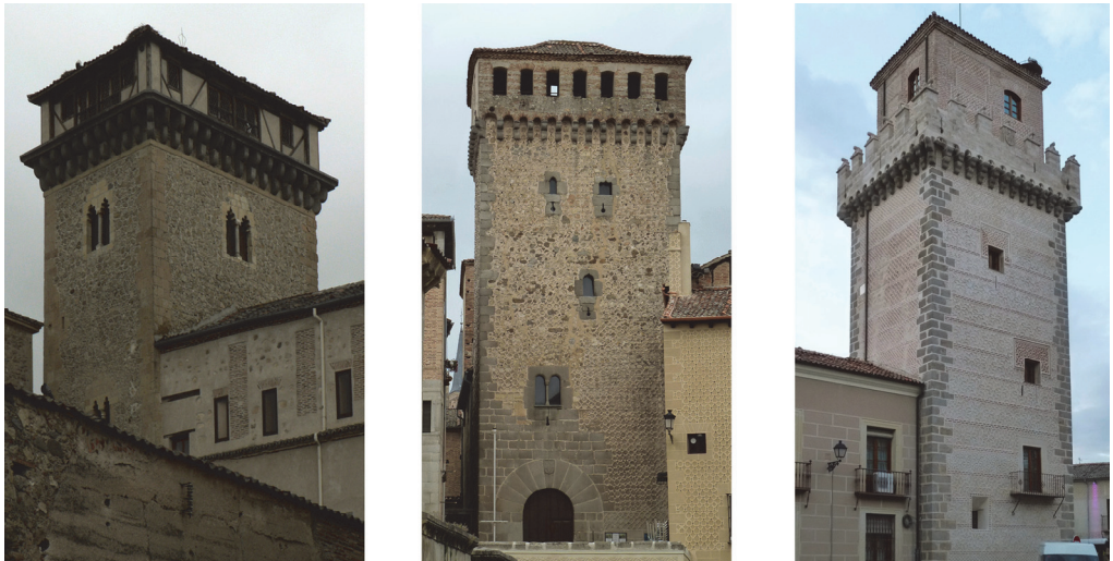
Figura 2.- Los tres torreones singulares de la ciudad: Hércules, Lozoya y Arias Dávila, con habitáculo superior sobre adarve colgado sobre ménsulas de granito (fotos autora).
