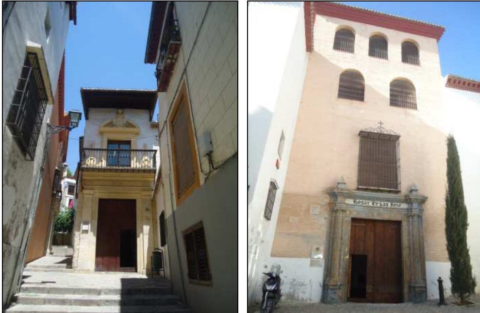
Figs. 3 y 4. Sede de la actual Fundación Albayzín. Palacio del Almirante, actual sede de la Escuela de Restauración de la Universidad de Granada.
